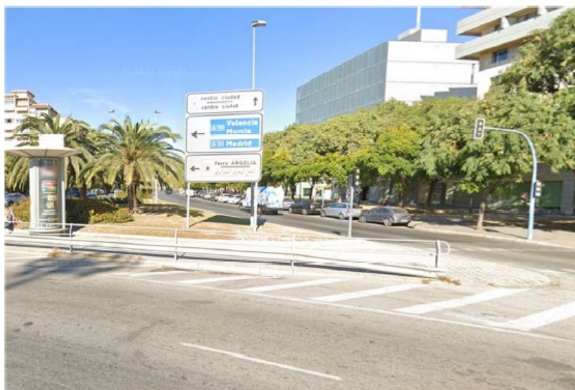
Figura 4. Perímetro exterior donde no existe riesgo de caída a distinto nivel.
